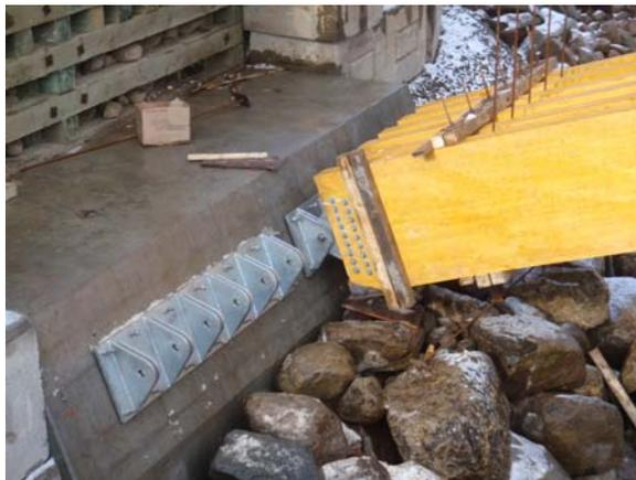
Photo 7 : Fixation des poutres arquées au massif de béton
