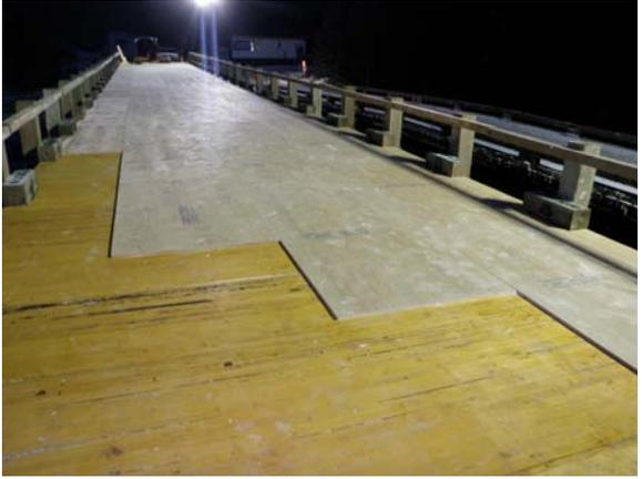
Photo 8 : Mise en place des contreplaqués sur les panneaux en bois lamellé-collé
