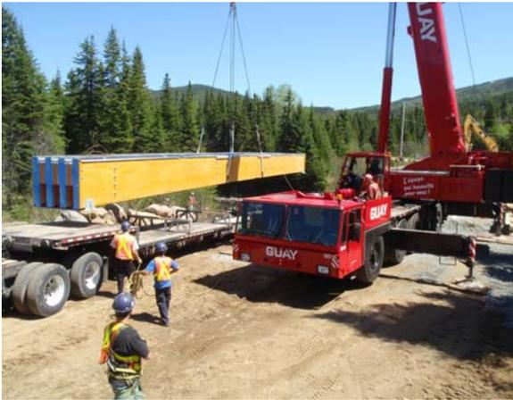
Photo 1 : Mise en place des poutres préassemblées
