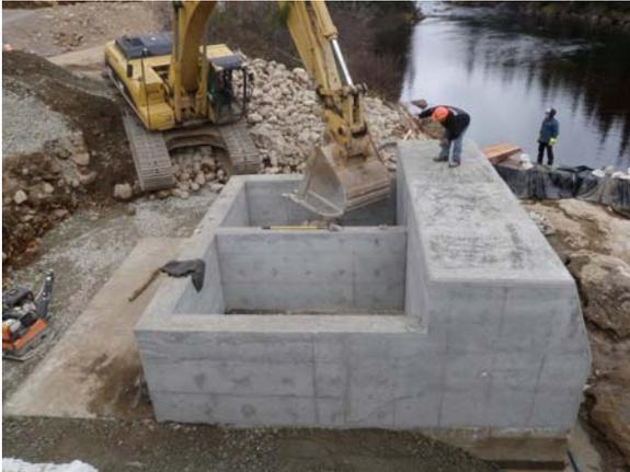
Photo 4 : Construction d'un massif de fondation en béton armé
