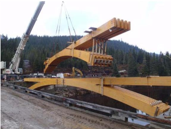
Photo 6 : Mise en place de la structure d'un caisson composé de 6 poutres arquées et 5 poutres droites
