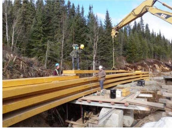
Photo 5 : Banc d'assemblage des poutres
