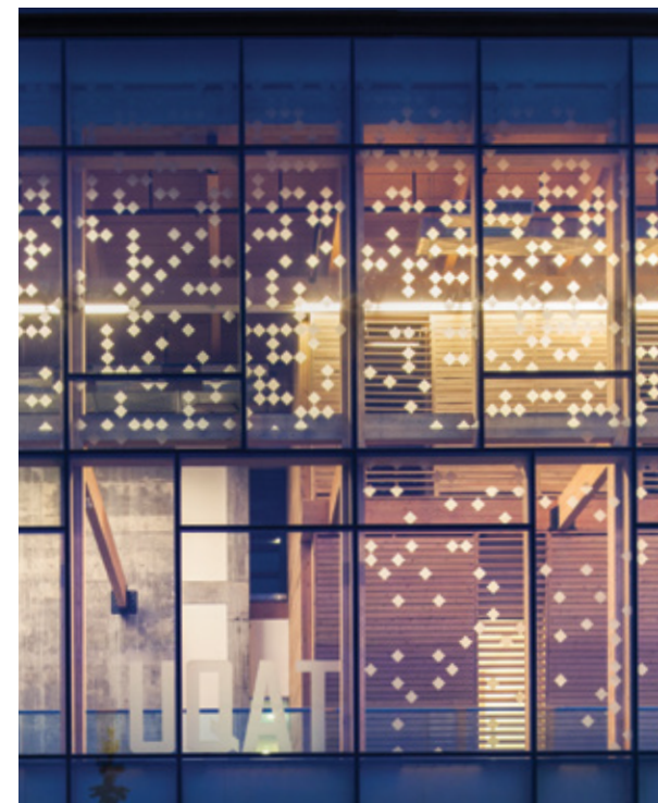
Fig. 1 : Façade vitrée permettant d'apprécier la structure en bois The timber structure is showcased through a glass facade
