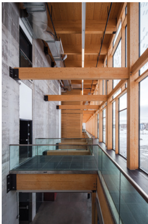
↑ Fig. 2: Détail de connexion de la structure de bois au mur de refend en béton Connection detail between the wood structure and the concrete shearwall
